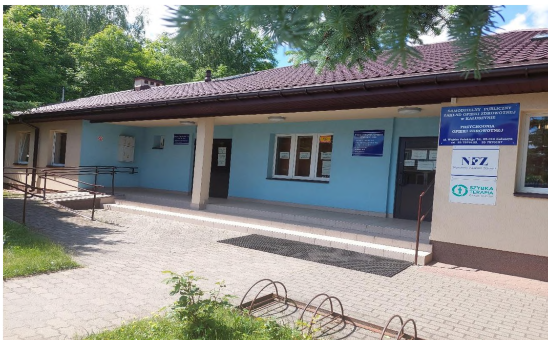
Budynek przychodni Zdrowia przy ul. Wojska Polskiego 24
